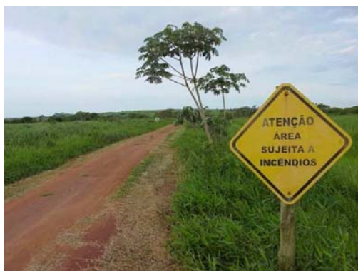
FIGURA 232-III- VISTA PARCIAL DA ESTRADA DO BANHADO E DETALHE DE SINALIZAÇÃO.
