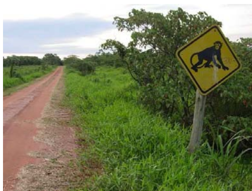
FIGURA 233-III- VISTA PARCIAL DA ESTRADA DO BANHADO E DETALHE DE SINALIZAÇÃO.
