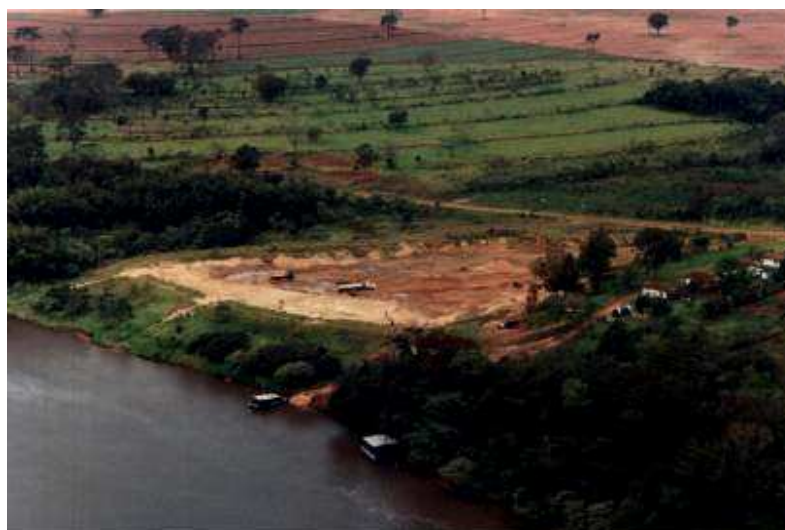
FIGURA 30-II - VISTA AÉREA DE PORTO DE AREIA ÀS MARGENS DO RIO PARANÁ, MUNICÍPIO DE GUAÍRA-PR.
