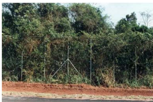
FIGURA 65-III - ASPECTO DO ALAMBRADO INSTALADO AO LONGO DA BORDA DA MATA DO BUGIO JUSTAPOSTA À CABECEIRA DA PONTE SOBRE O CANAL LESTE.
