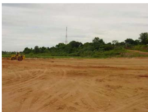
FIGURA 136-III- VISTA PARCIAL DO PORTO BYINGTON OU VILA YARA, MUNICÍPIO DE ALTÔNIA-PARANÁ, EM LOCAL DE DEPÓSITO DE AREIA.
