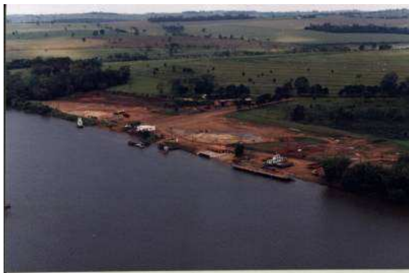
FIGURA 29-II - VISTA AÉREA DE PORTO DE AREIA ÀS MARGENS DO RIO PARANÁ, MUNICÍPIO DE GUAÍRA-PR.
