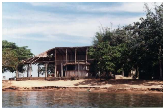
FIGURA 220-III- INFRA-ESTRUTURA NA PRAIA DAS GAIVOTAS, MUNICÍPIO DE GUAÍRA-PR.
