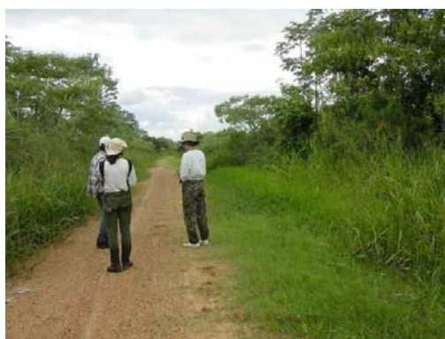
FIGURA 38-III - ASPECTO DA ESTRADA DA Balsa ABANDONADA, PRÓXIMO AO PONTO IGS06P65.
