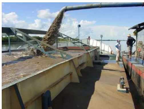
FIGURA 133-III- DRAGA DE AREIA EM OPERAÇÃO.
