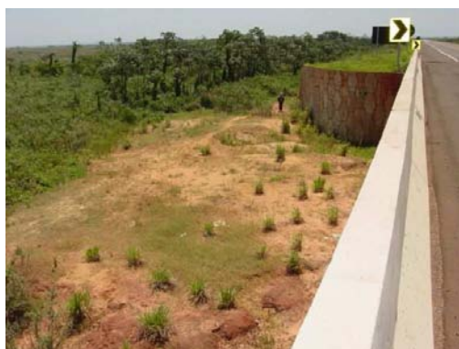
FIGURA 214-III- ASSOAREAMENTO E COMPACTAÇÃO DE SOLO NA LAGOA DO JACARÉ, RODOVIA DENTRO DO PARQUE NACIONAL DE ILHA GRANDE.
