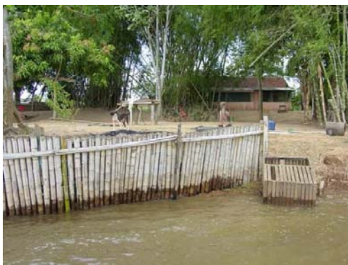
FIGURA 45-III - DETALHE DE PROPRIEDADE ATIVA NO NORTE DA ILHA PERUZZI.
