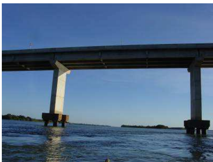
FIGURA 34-II - COMPLEXO DE PONTES “LUIZ EDUARDO MAGALHÃES” – PONTE SOBRE O CANAL LESTE DO RIO PARANÁ
