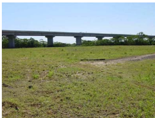
FIGURA 64-III - ASPECTO DO ANTIGO CANTEIRO DE OBRAS UTILIZADO DURANTE A CONSTRUÇÃO DO COMPLEXO DE PONTES LUIZ EDUARDO MAGALHÃES, NA ILHA BANDEIRANTES.
